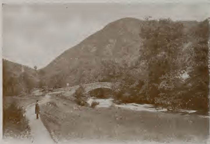
ABER BRIDGE, ABER.
